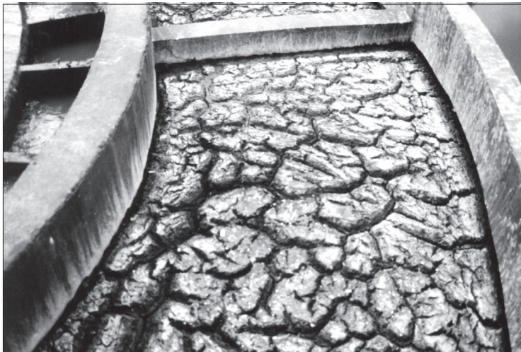
Figura 7.14 Camada solidificada de espuma no compartimento de gases de um reator anaeróbio tipo RALF.
