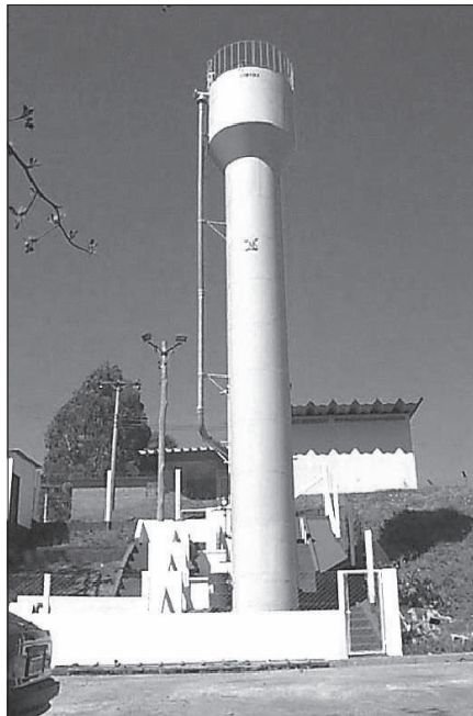
Figura 8.2 Reator anaeróbio de leito expandido/fluidificado, com altura total de 12,0 m (SHS-EESC-USP, São Carlos, SP, Brasil).
