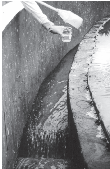
Figura 7.13 Dispositivo de coleta do efluente (placa com vertedores triangulares).
