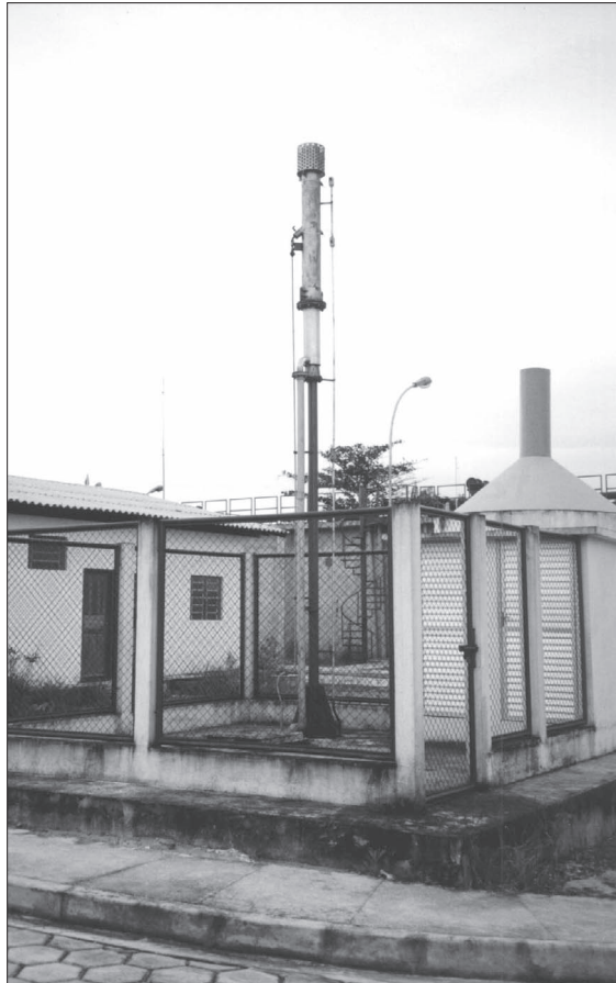
Figura 7.16 Vista de um queimador de gases de um reator UASB.
